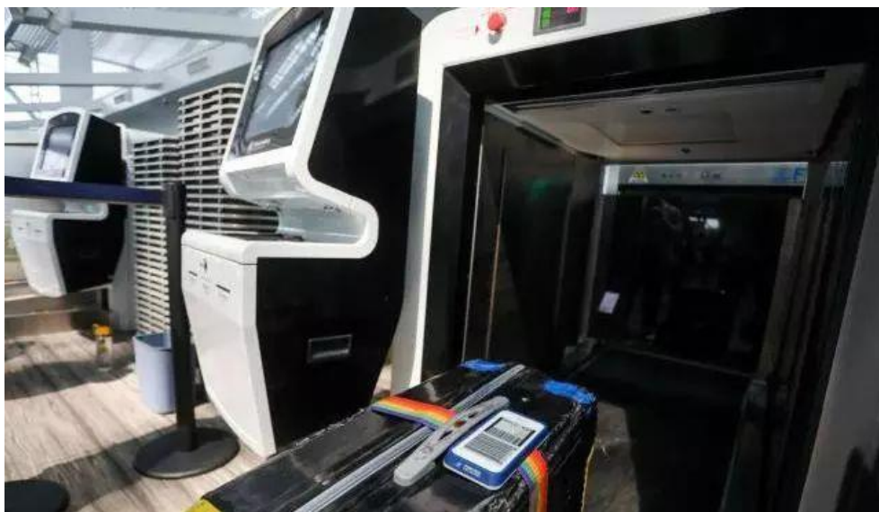
图 5-10 北京大兴国际机场 RFID 行李全流程跟踪系统
