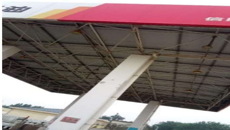
说明图 9.1.4-2 装卸油棚棚顶容易吸引鸟类筑巢
