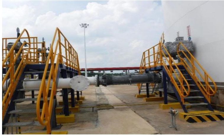
说明图 6.1.4-6 管线上部简易跨桥
