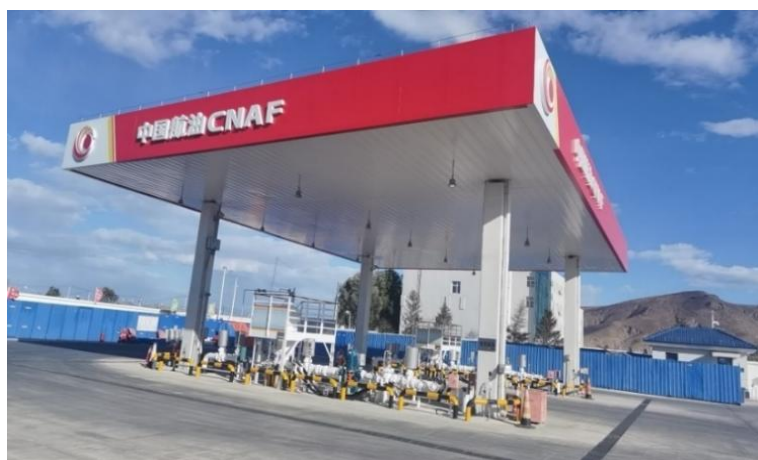
说明图 9.1.4-3 装卸油棚棚顶吊顶
