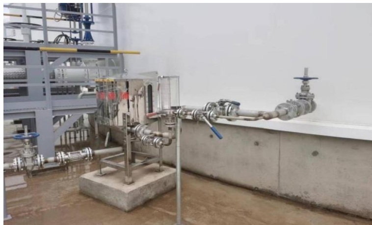
说明图 6.1.4-2 油罐旁带视窗的质量检查桶
