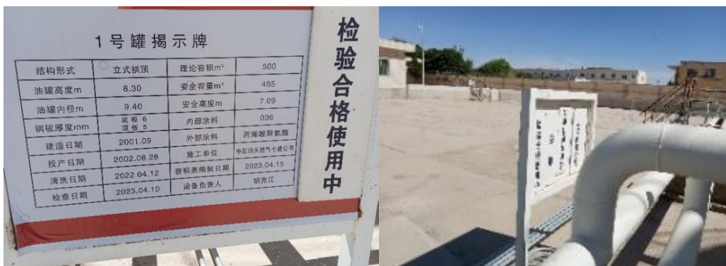
图 11.1.7 储罐揭示牌使用磁铁式标牌显示油罐使用状态
