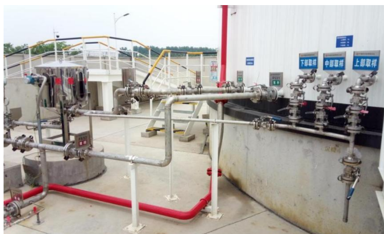
说明图 6.1.4-4 简单的三点取样设置
